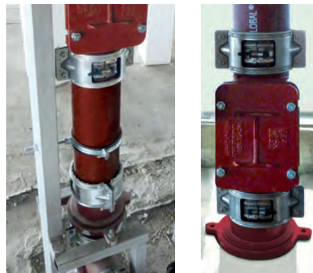
В закрытых системах установки опор трубопроводов не требуется
